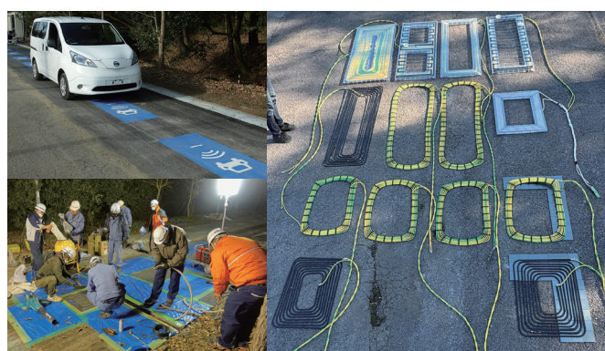
【図3・4・5】野田キャンパスにある約100 mのワイヤレス給電の走行路。実験用にさまざまなコイルが埋設されている
