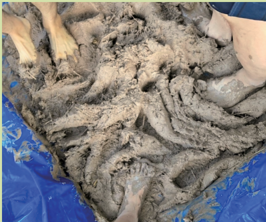
【写真4】足踏み。小石などが残っていないか確認。粘土のチキソトロピーの性質を利用し、踏むことにより、混和し易くなる。
