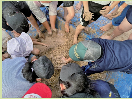
【写真3】真砂土と藁と混和。常総粘土の収縮力を抑えるため、収縮しない真砂土とひび割れを抑える藁を混和。
